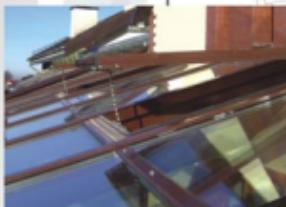
Télikertekben vagy üveghomlokzatoknál alkalmazott, tetősíkba szerelhető ablak. Kifelé nyitható manuálisan, vagy elektromos vezérléssel.
